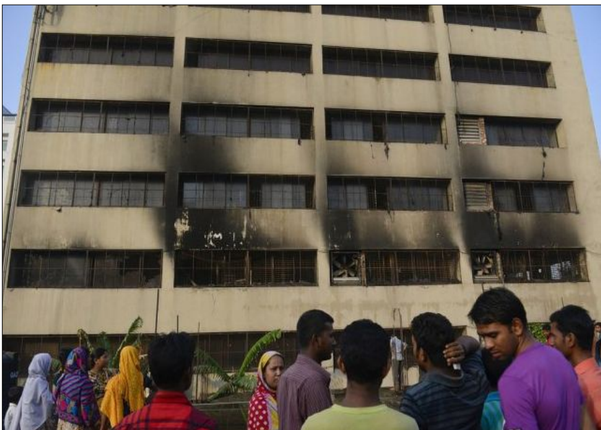
آتش سوزی در کارخانه پوشاک در داکا
